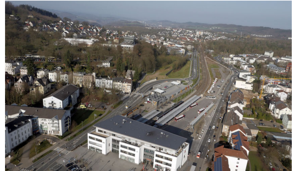
Schrägluftbild: Stadtbahnhof und Plangebiet
